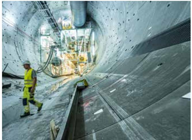
Arbeiten im Belchentunnel an der grössten Tunnelbohrmaschine der Schweiz – Durchmesser 13,97 Meter.
